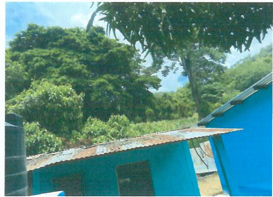
FOTO 2: Cambio de cubierta con lámina troquelada calibre 26, pintura, mejoramiento de puerta, balcón y cambio de ventanas
